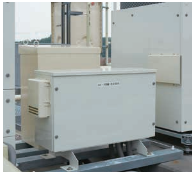
・自立発電切り替え用の電源ボックス(現地調達品)。背後に自立ボックス。
