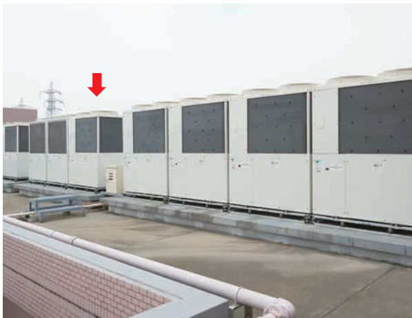
・中央左側にエクゼア停電時自立発電タイプ(20馬力)
