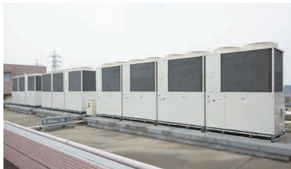
・建屋上上の東西両側に半分ずつ合計19台の室外機を設置。既設空調機の基礎も有効利用。
